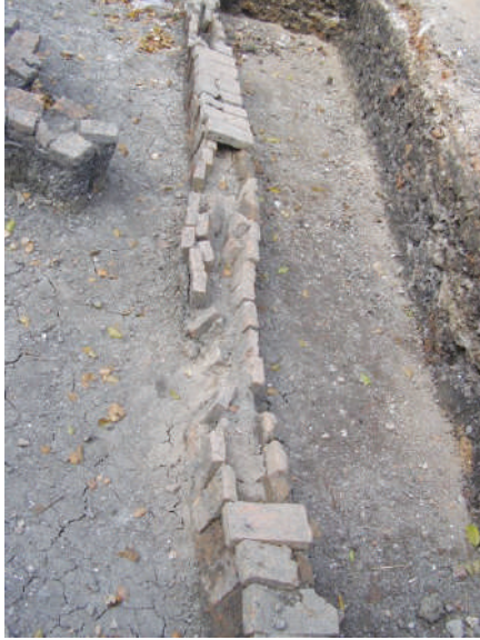
รางระบายโบราณ ใช้อิฐก่อเป็นแนวรางระบาย แล้วใช้อิฐวางด้านบนเป็นฝาปิด
