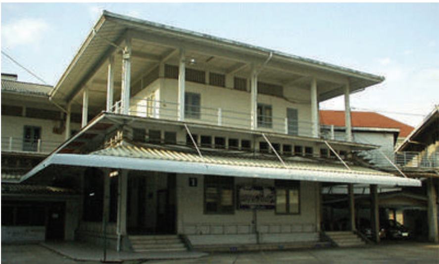
ศาลาแยกธาตุก่อนการรื้อถอน
