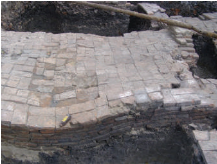
ภายในอาคาร ใช้อิฐปูพื้น โดยเรียงอิฐด้านสั้น สลับด้านยาวสองก้อน ด้านข้างก่อเป็นผนังอิฐ
